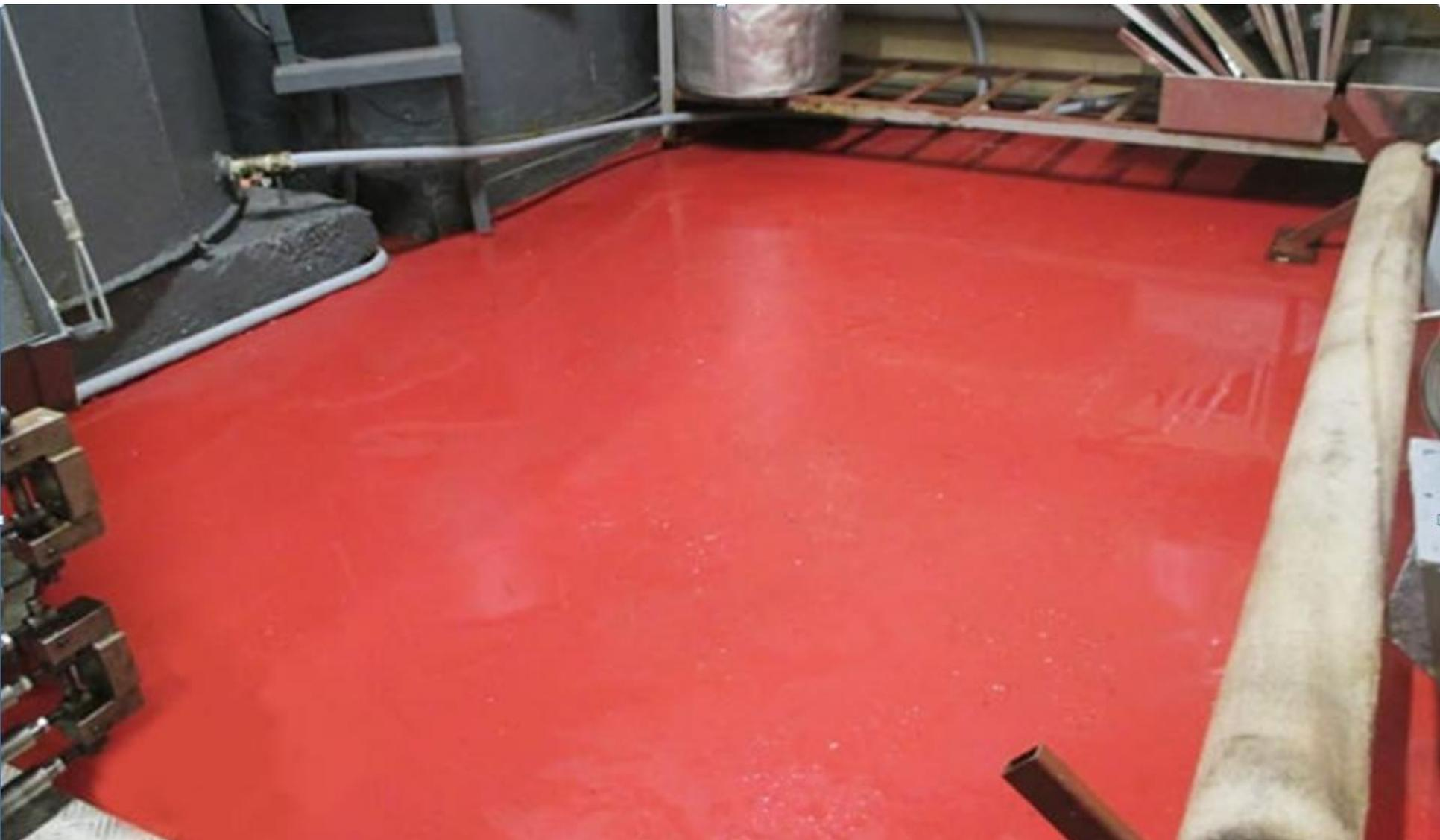
**Устройство полиуретанового полимерного наливного пола PRIMAFLOOR PR.21**
